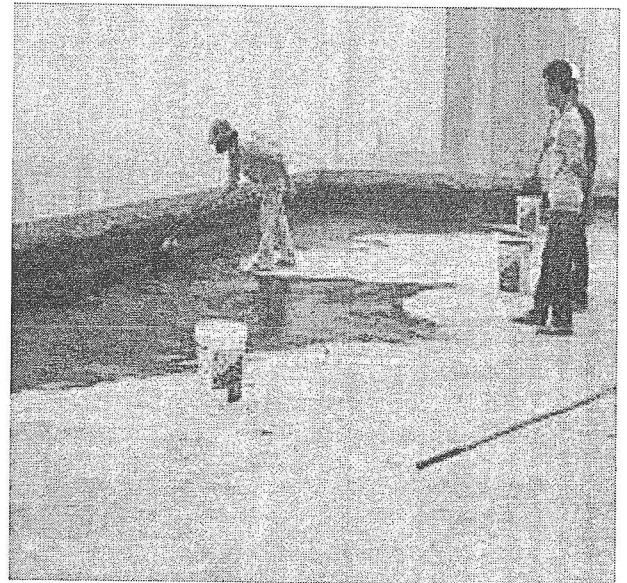
Quét lớp màng chống thấm
