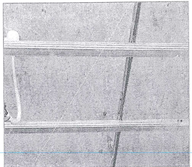
Khi hệ khung xương được lắp, phải căng dây theo các phương: ngang, dọc, chéo để kiểm tra mặt phẳng của cả hệ
