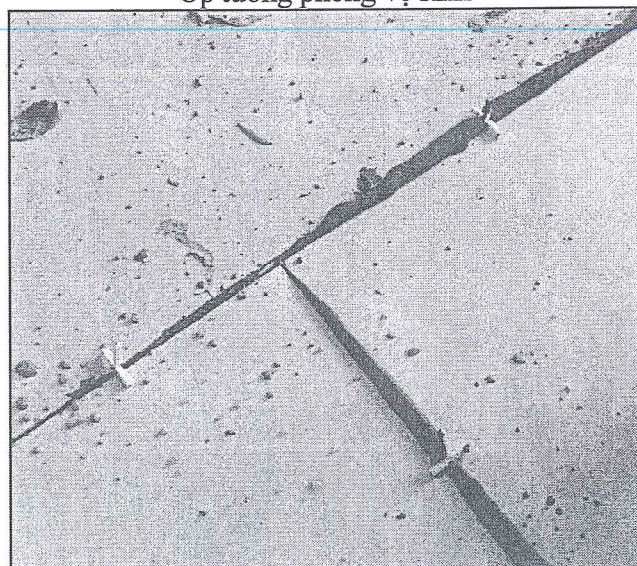
Dùng cữ chữ thập để tạo đường roăng đều
